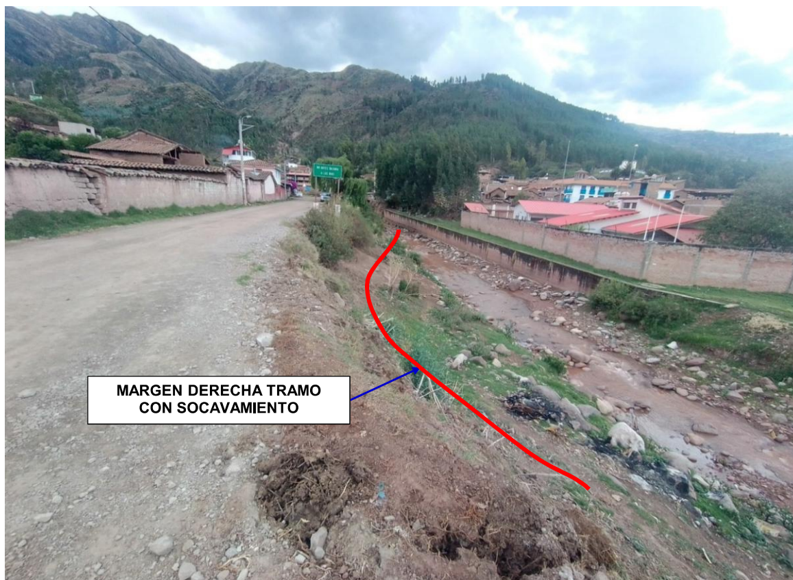
FIGURA N° 03: EN LA TEMPORADA DE MAXIMAS AVENIDAS, LA QUEBRADA MARPA PROVOCA SOCAVAMIENTO EN LA MARGEN DERECHA.
