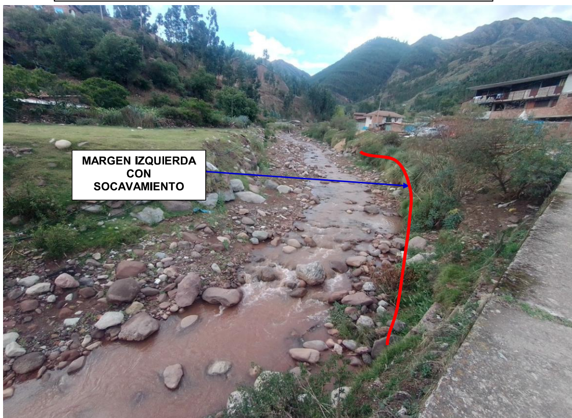
FIGURA N° 02: QUEBRADA MARPA EXPUESTO ANTE SOCAVAMIENTO EN EL CERCADO DEL DISTRITO DE ACOMAYO.
